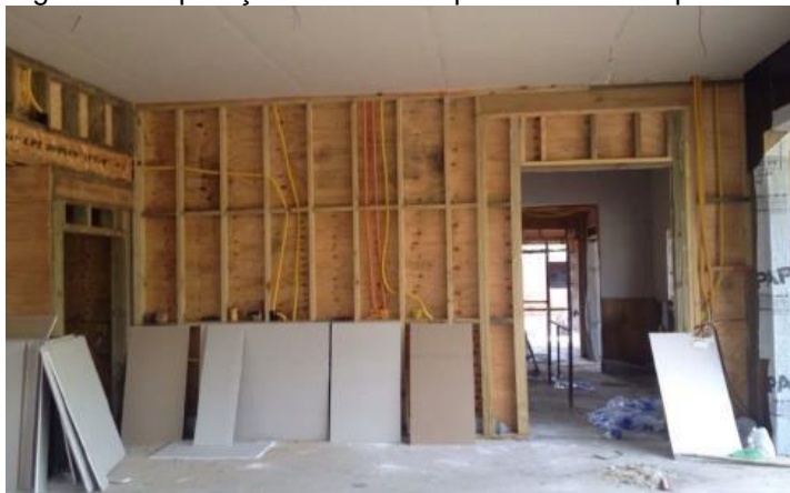
Figura 5: Preparação elétrica nas placas nas OSB pelo forro.
