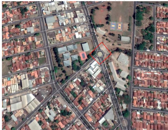
Figura 3.2.2: Trecho da obra
