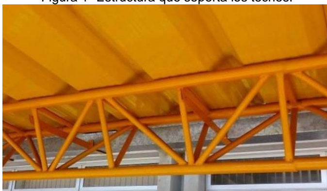
Figura 1- Estructura que soporta los techos.
