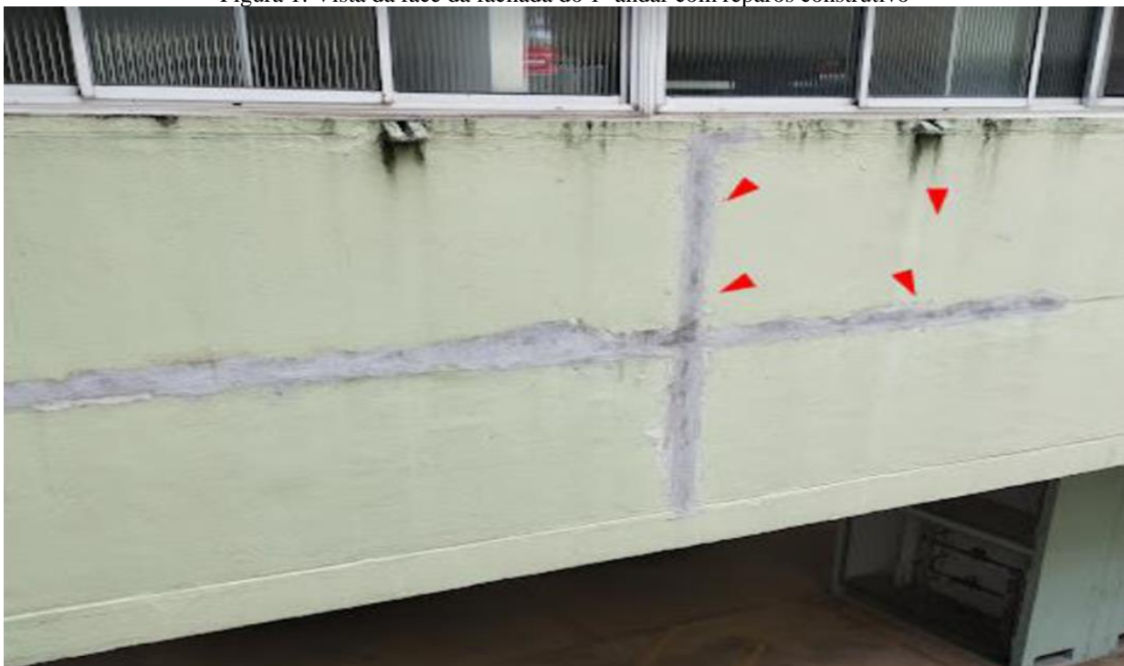
Figura 1: Vista da face da fachada do 1º andar com reparos construtivo
