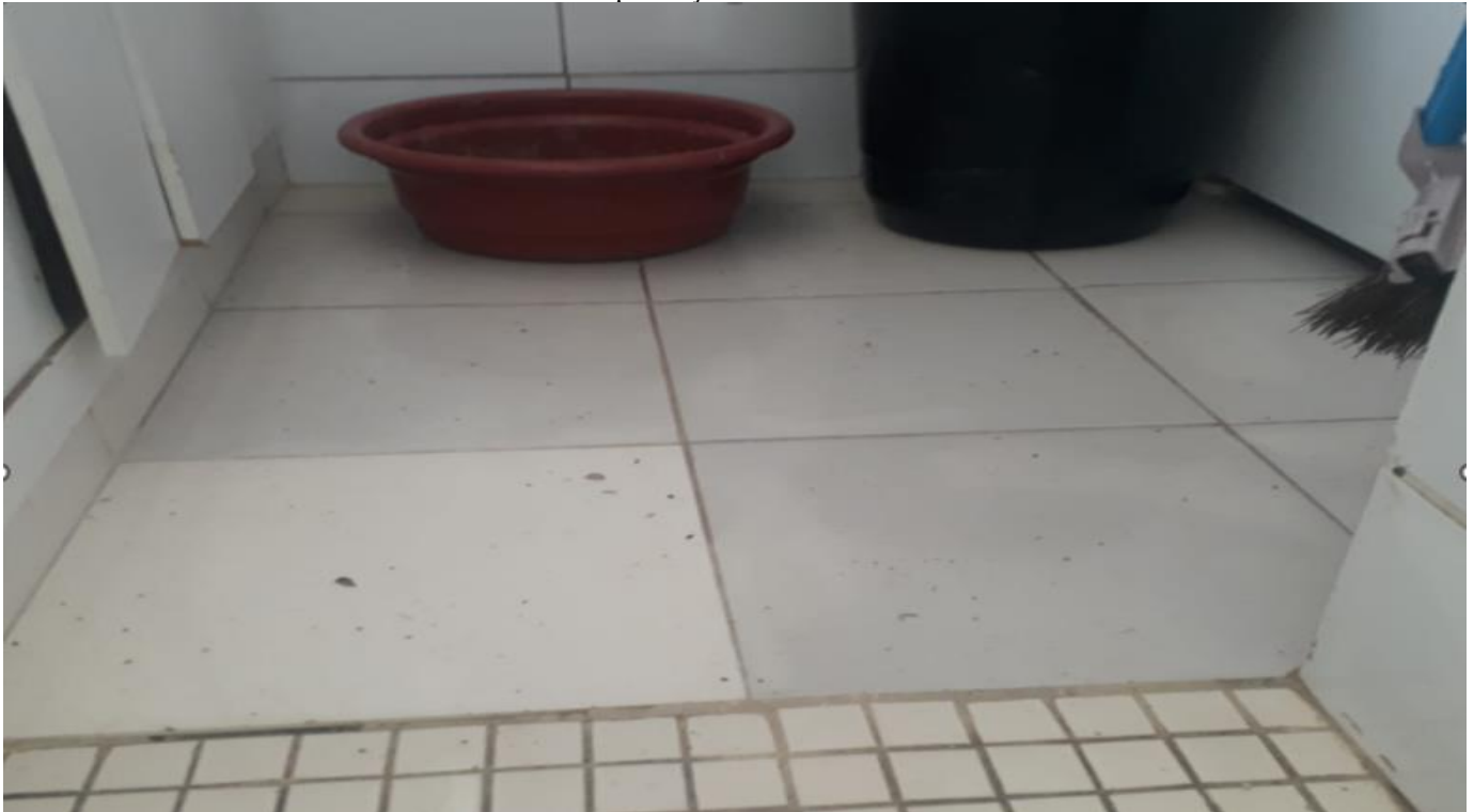
Figura 6: Vista interna do apartamento 1º andar, diferença de tonalidade entre os pisos onde a região mais escura indica presença de umidade
