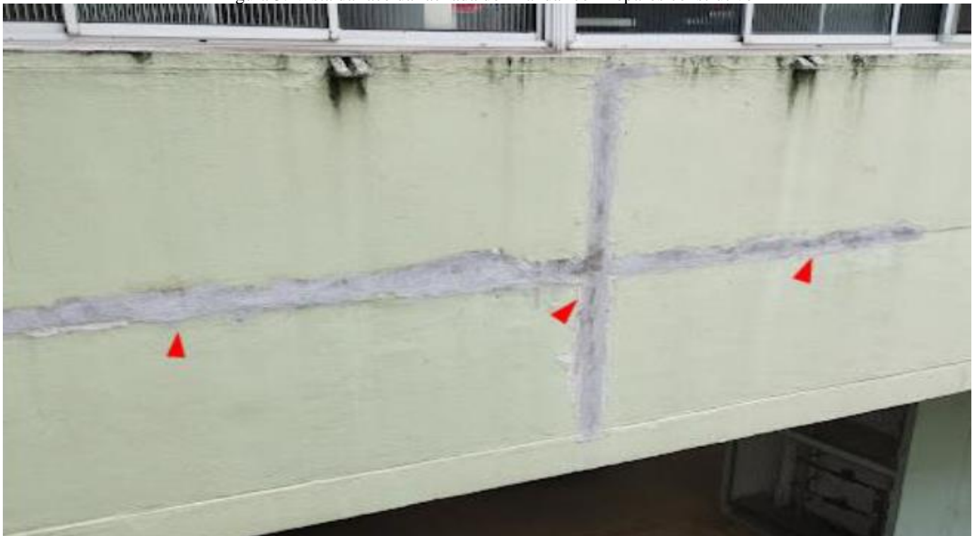
Figura 3: Vista da face da fachada do 1º andar com reparos construtivo
