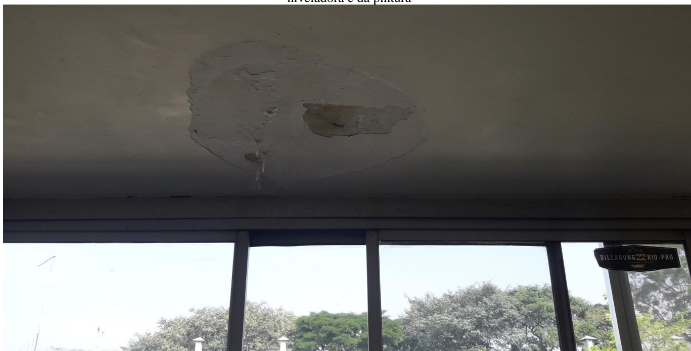
Figura 10: Vista interna do apartamento 3º andar. Infiltração na sala e formação de estalactites, deslocamento da massa niveladora e da pintura
