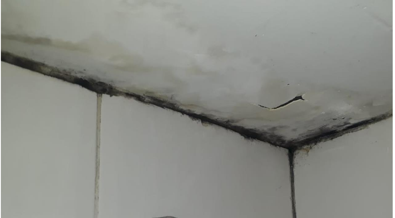
Figura 20: Vista interna do apartamento 3º andar, nicho do armário com bolores e fungos
